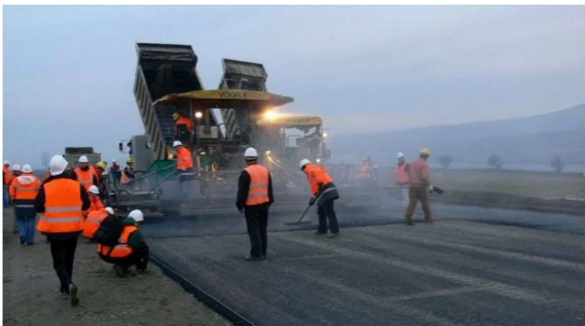
Рис. 1. Процесс работы механика в строительстве
