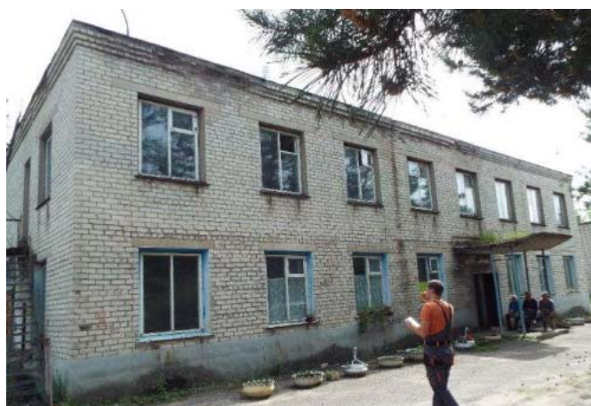
Рис. 1. Общий вид здания производственного корпуса
