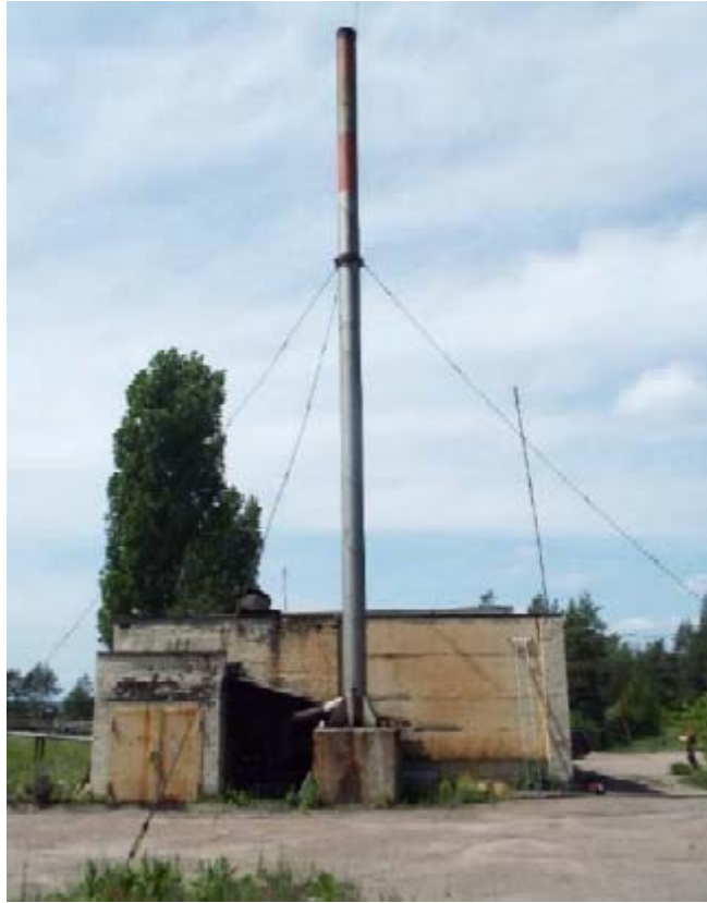
Рис. 1. Общий вид дымовой трубы
