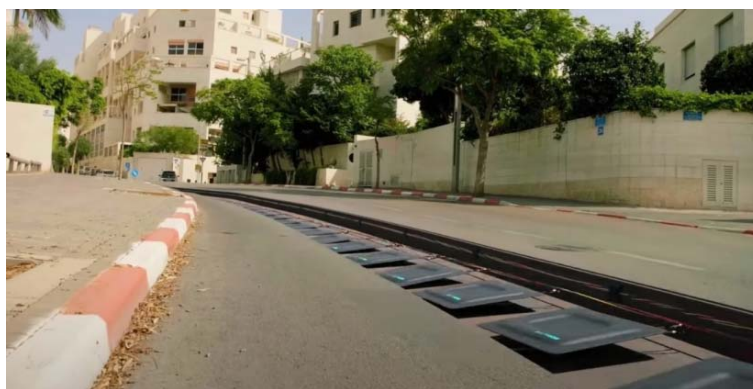
Рис. 4. Визуальное представление расположения пластин под проезжей частью
