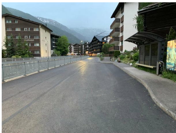
Рис. 4. Участок автомобильной дороги с применением пластмасс г. Церматт Швейцария
