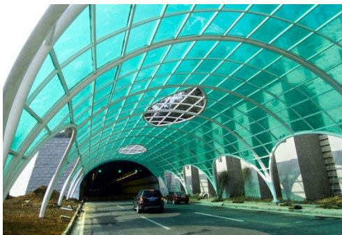
Рис. 2. Полная изоляция дороги акустическими экранами
