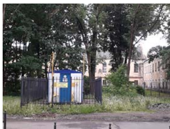
Рис. 14, 15. Шкафной газорегуляторный пункт, дендропарк, Псков; блочный газорегуляторный пункт, детский парк, Псков (фото К.Шишов)
