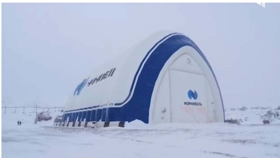
Рис. 2. Ремонтный бокс для обслуживания строительных машин
