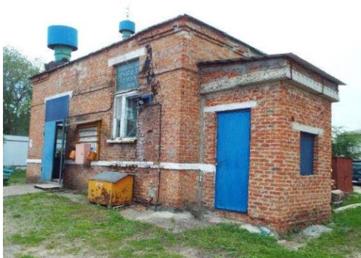
Рис. 1. Общий вид сооружения КНС
