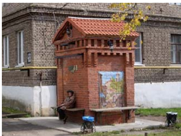
Рис. 10. Старая трансформаторная будка
