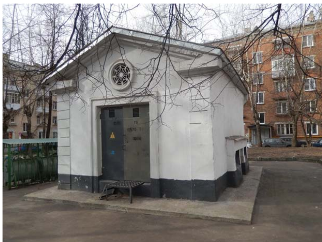
Рис. 12. Действующая ТП 10 кВ после реконструкции, Перово, Москва
