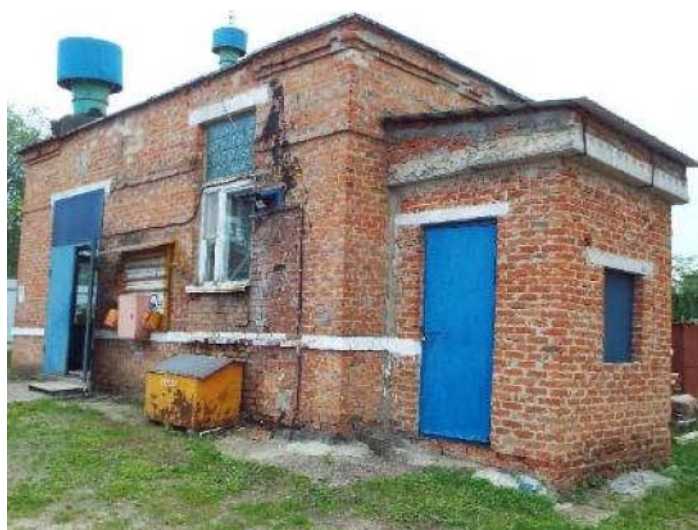
Рис. 6. Повреждение отмостки по периметру КНС
