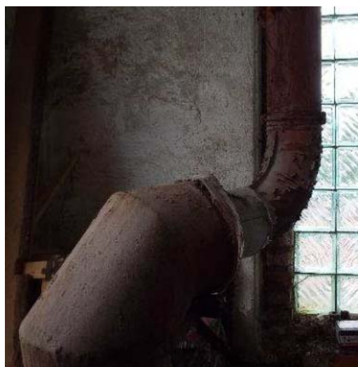
Рис. 5. Системы отопления и вентиляции КНС неисправны
