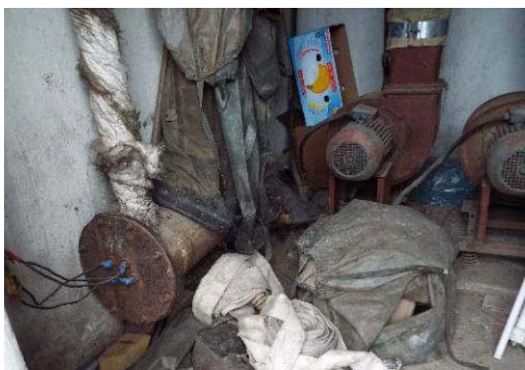
Рис. 5. Системы отопления и вентиляции КНС неисправны
