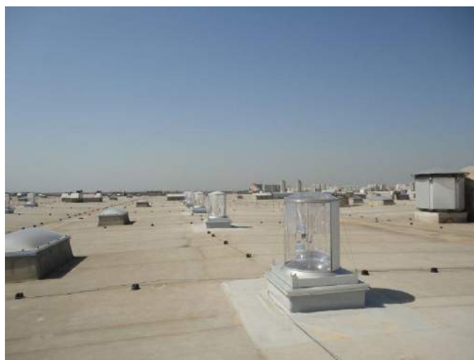
Рис. 5 – Внешний вид кровли с гибридным освещением
