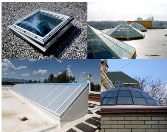
Рис. 2 – Зенитные фонари в гражданских зданиях
