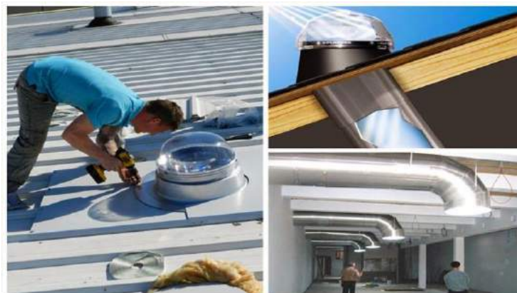
Рис. 4 – Световой колодец
