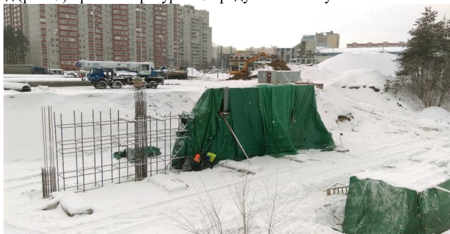
Рис. 5. Бетонные работы в зимних условиях
