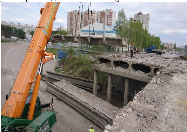
Рис. 2. Демонтаж моста
