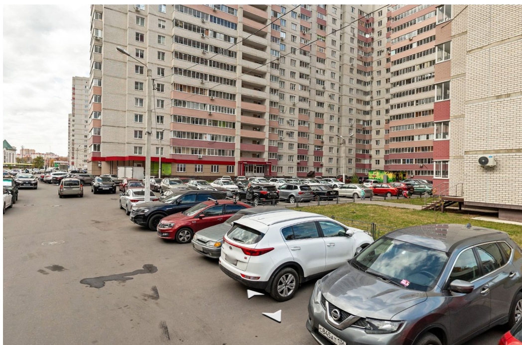
Рис. 1. Пример существующих проблем сложившейся застройки в области благоустройства
