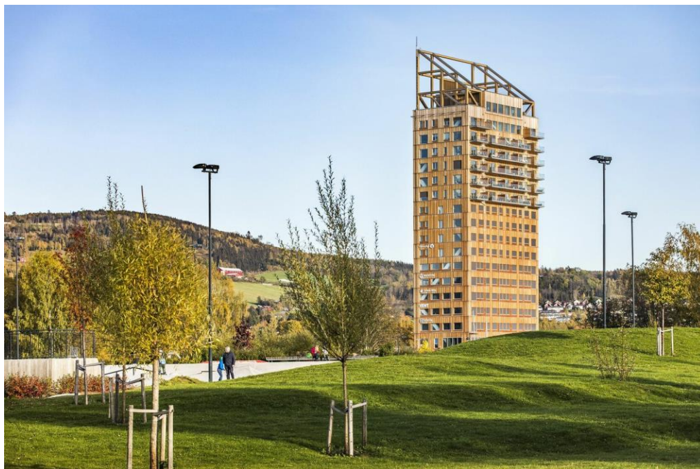
Рис. 1. Башня Mjøstårnet, Брумунддал, Норвегия
