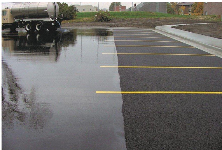
Рис. 7. Пористое покрытие (справа) и обычный асфальт (слева)
