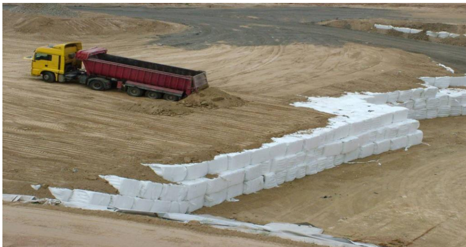
Рис. 2. Засыпка твёрдых отходов
