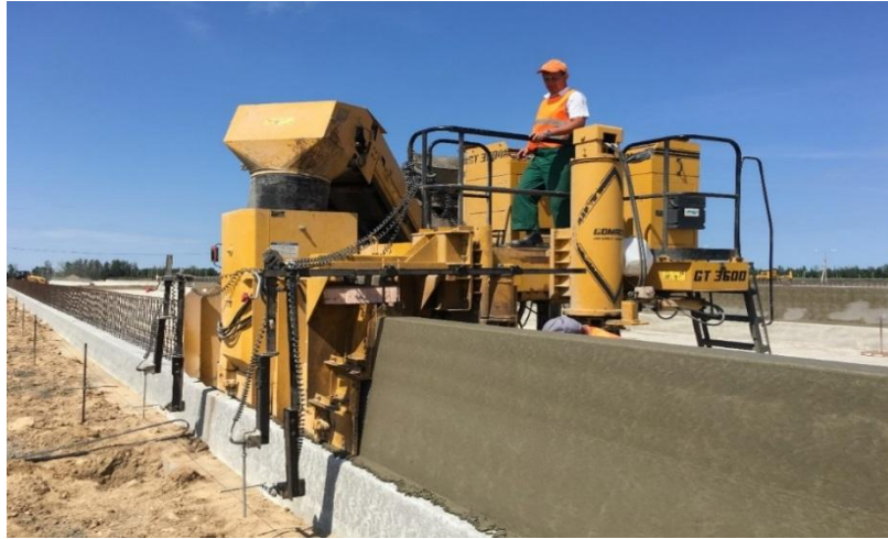
Рис. 3. Бетоноукладчик монолитных профилей GOMAKO GT-3600
