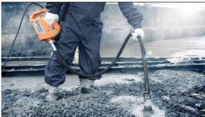
Рис. 9. Уплотнение глубинным ручным вибратором
