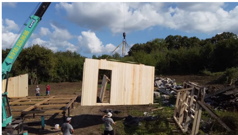
Рис. 3. Процесс монтажа CLT-панели
