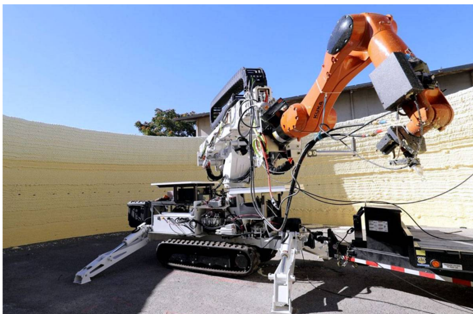
Рис. 2. Применение робота на строительной площадке
