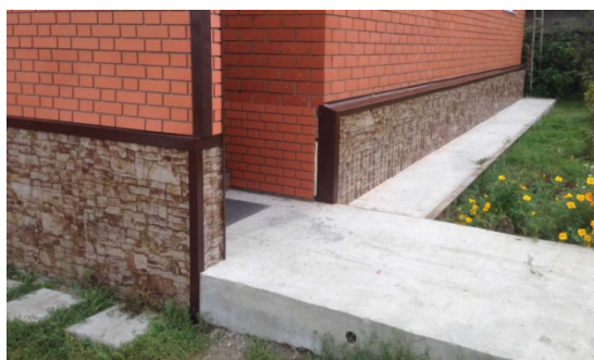
Рис. 3. Отделка цоколя профнастилом
