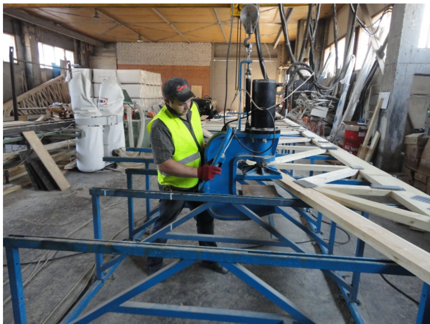
Рис. 3. Сборка элементов каркаса на производстве
