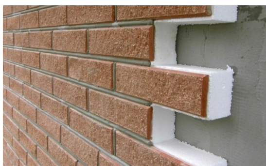
Рис. 4. Отделка цоколя термопанелями
