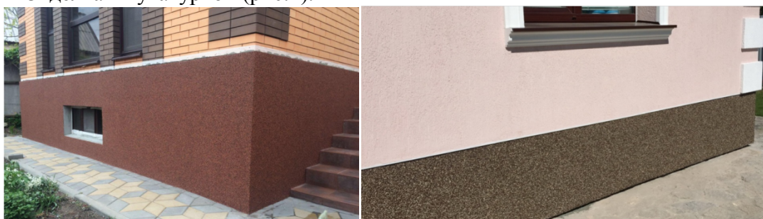
Рис. 1. Отделка цоколя штукатуркой
