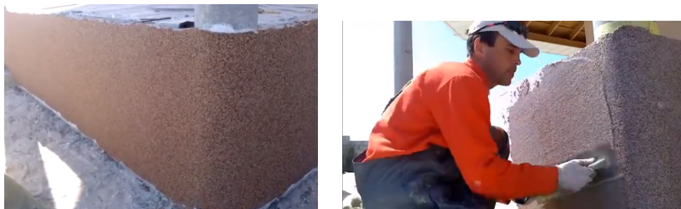
Рис. 2. Отделка цоколя мозаичной штукатуркой
