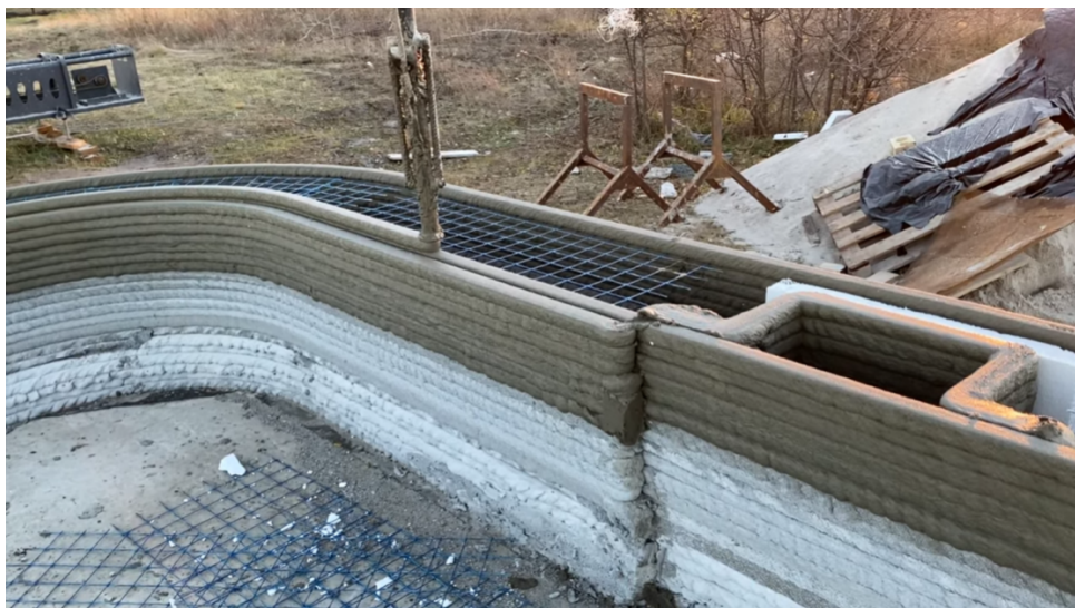
Рис. 3. Арматурная сетка, уложенная на свеженапечатанный слой
