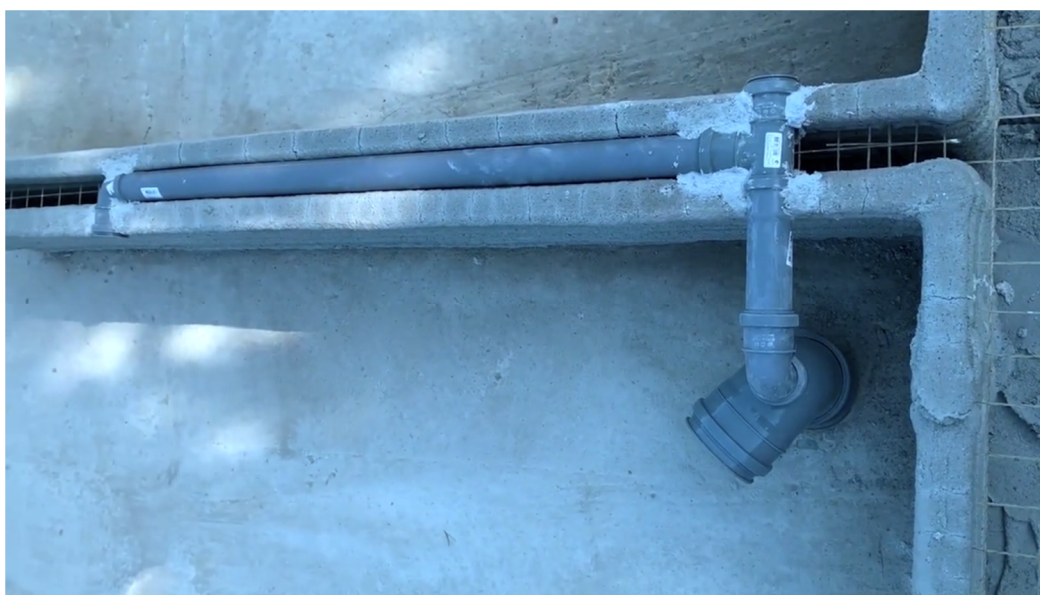
Рис. 5. Инженерные коммуникации в несъемной опалубке
