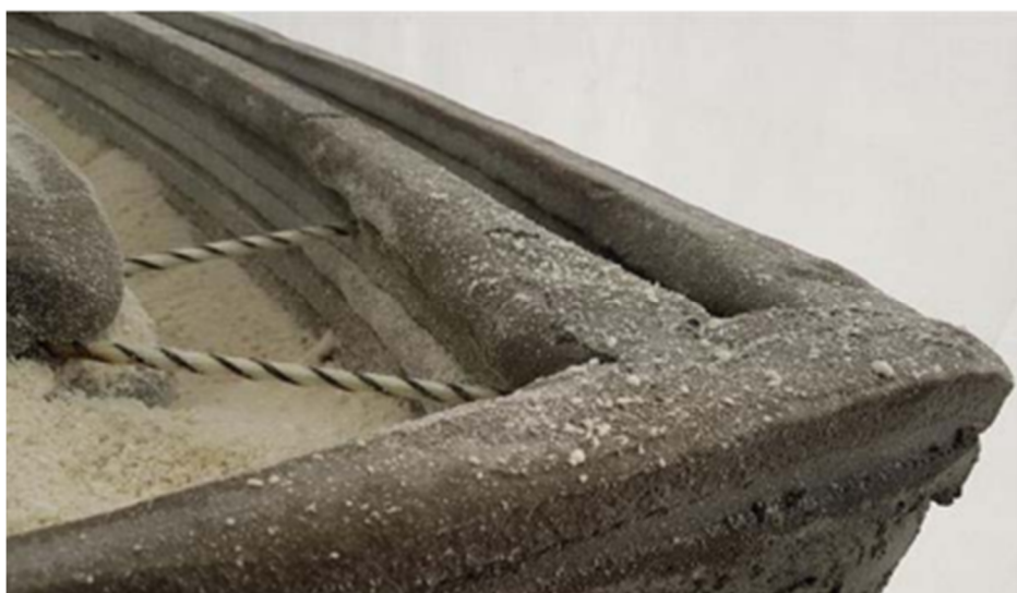
Рис. 4. Горизонтальная арматура в несъемной опалубке
