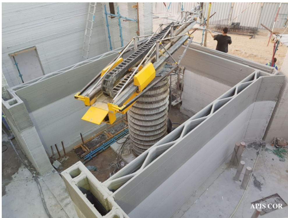
Рис. 2. Конструкция стены с ребрами жесткости при 3D-печати
