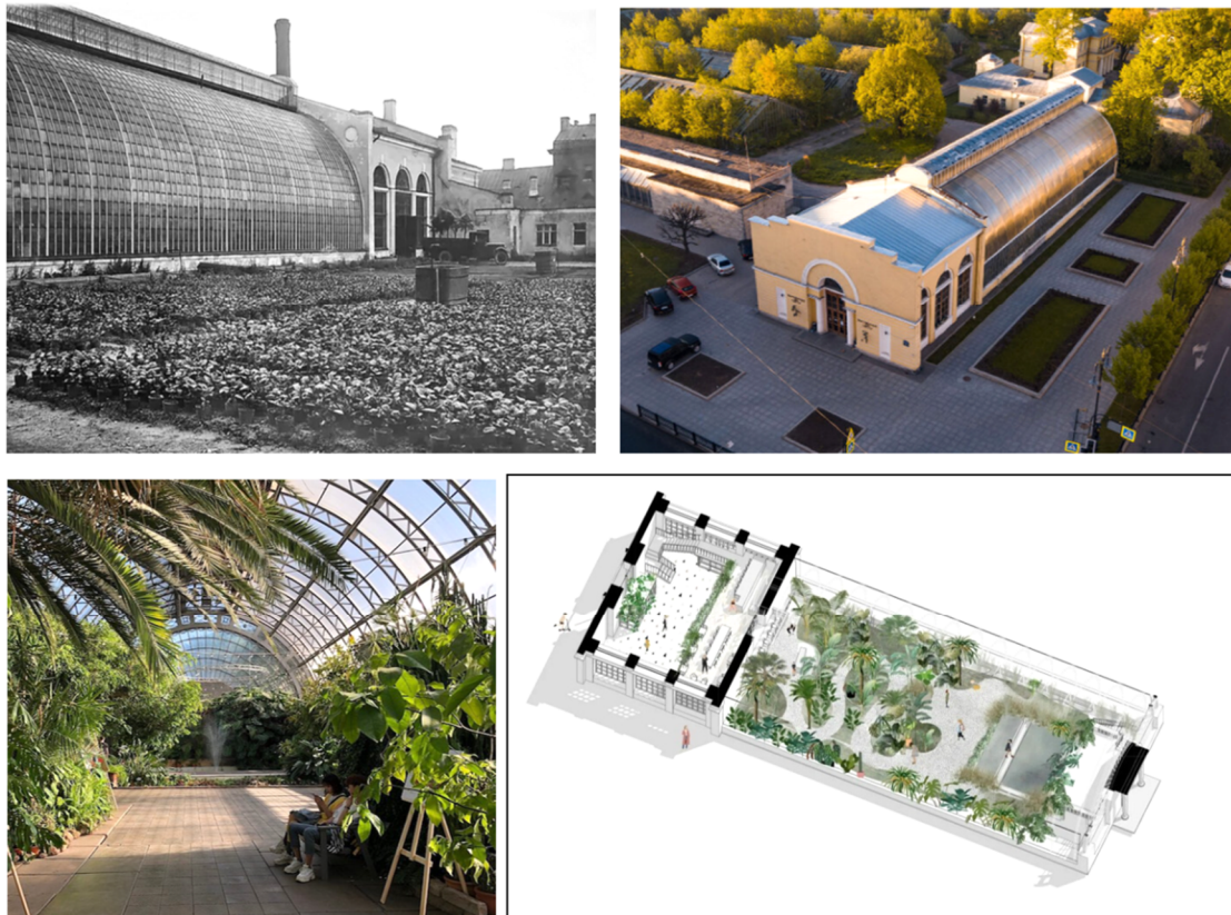
Рис. 3. Оранжерея Таврического сада, Санкт-Петербург, 1935 г. Здание оранжереи до реконструкции, 1937 г. Вид на здание оранжереи в наше время (после реконструкции 1977 г.). Внутреннее пространство. Схема внутреннего пространства. Архитектор: А.Р. Бах [19; 20; 23].
