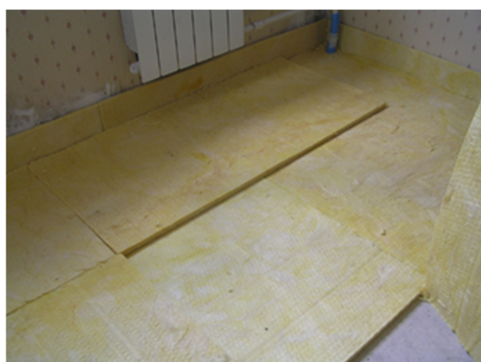
Рис. 1. Применение плит Шумостоп – C2 ( www.acoustic.ru )
