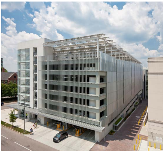
Рис. 7. Парковка «Green Square», США. Источник: https://www.archdaily.com [10]
