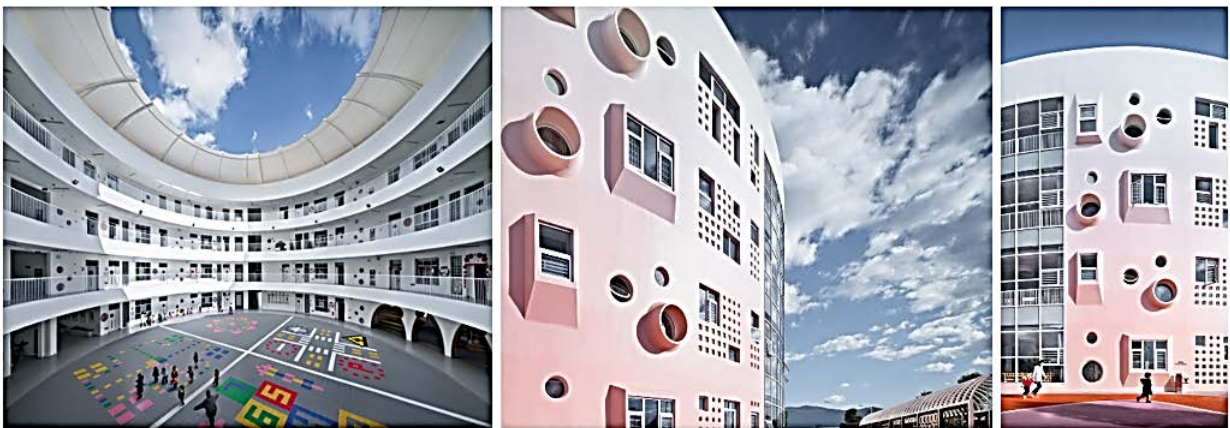
Рис. 5. Детский сад в провинции Юньнань. Китай. 2019 г. Внешний вид, концептуальные схемы. Студия Dika Architectural Design [16].
